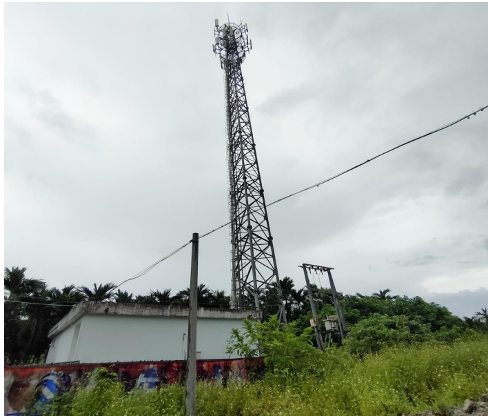
图2事故基站照片
